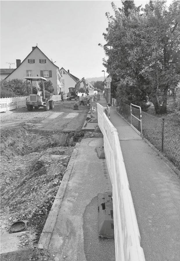
Die neue Trinkwasserleitung sowie die Breitbandleerrohre sind in der Hexentalstraße verlegt und die Hauptleitungsgräben sind neu verfüllt.
